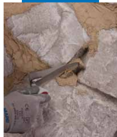
Výplň spár v kamenném zdivu
