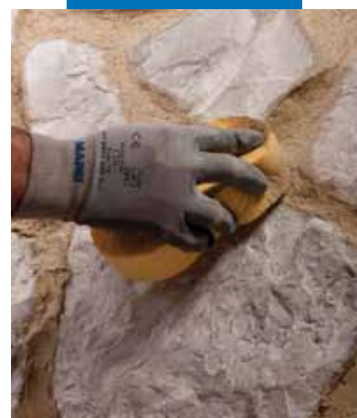
Konečná úprava povrchu houbou
