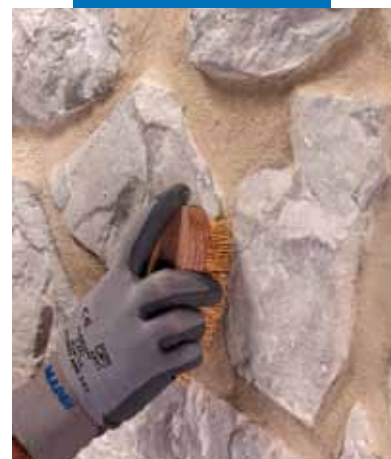
Konečná úprava povrchu kartáčem
