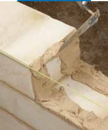
Aplikace Mape-Antique Allettamento
